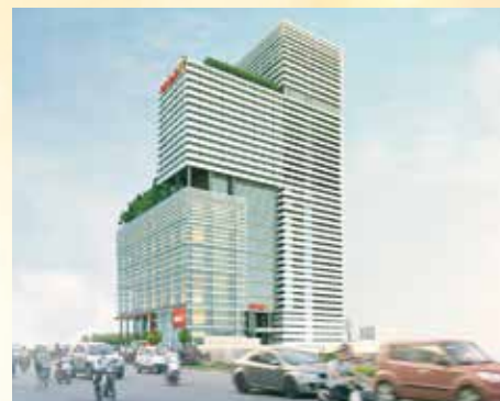
Trụ sở mới của Trung tâm Phát thanh - Truyền hình Quân đội tại 165 Xã Đàn, phường Nam Đông, quận Đống Đa, thành phố Hà Nội sẽ được đưa vào khai thác và sử dụng từ đầu năm 2019.
